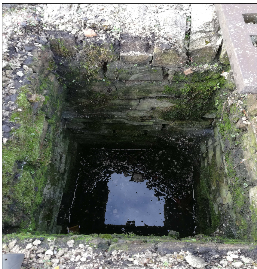
Obr. č. 14 - pohled do zanesené a zaplavené šachty Š5
