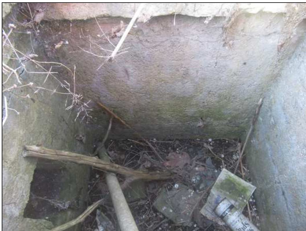
Obr. č. 6 - detailní pohled do zanesené šachty Š2, vlevo drenážní otvor směr Praha
