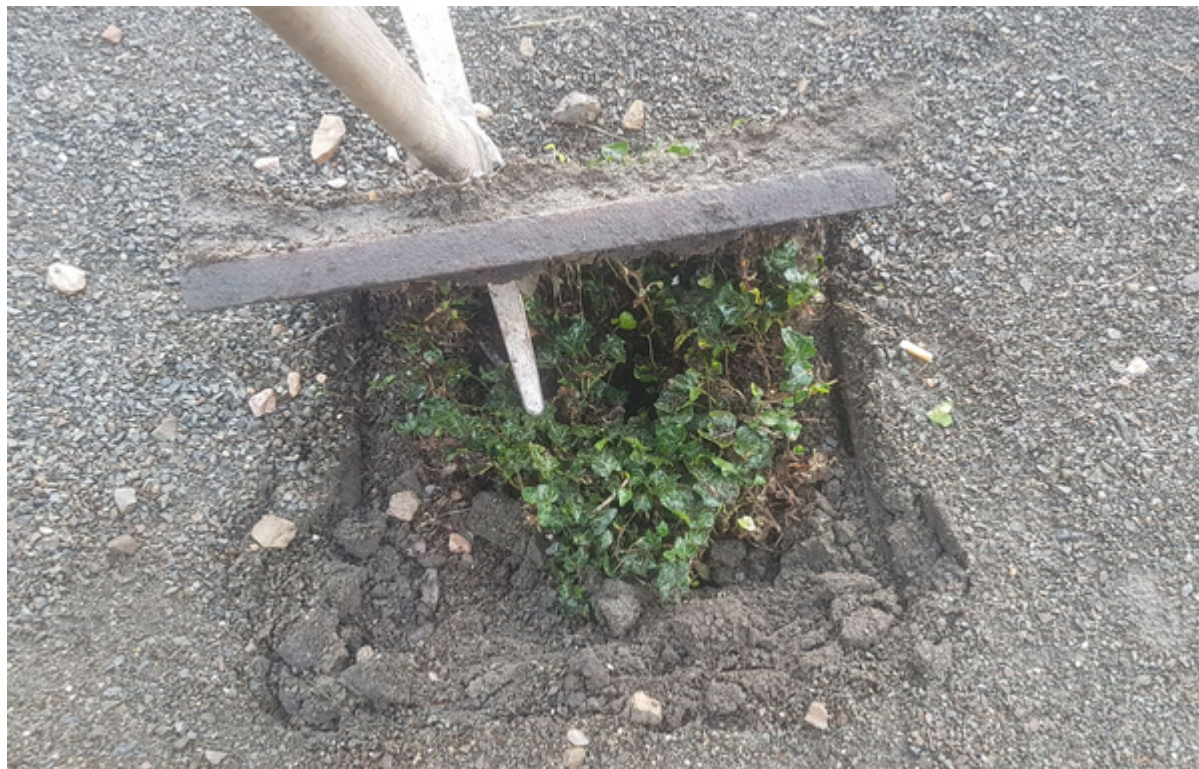
Obr. č. 5 - pohled do zcela zanesené šachty Š2
