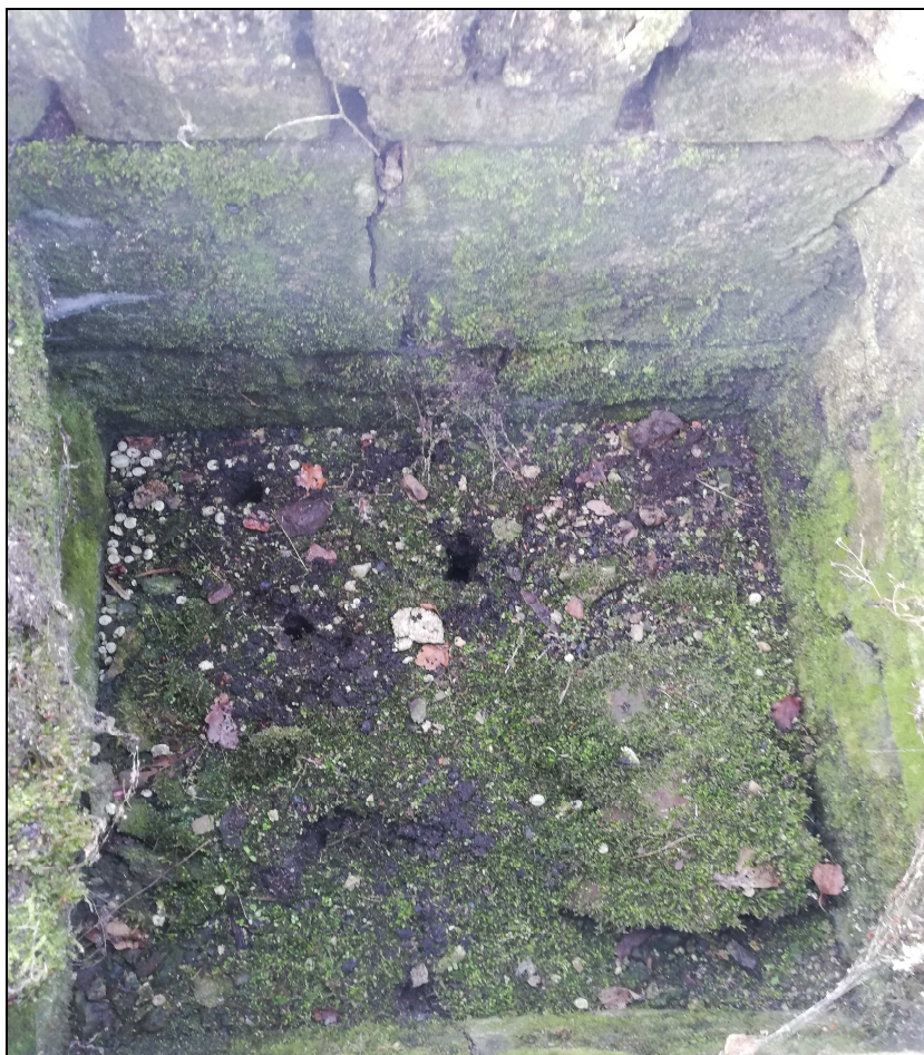
Obr. č. 12 - pohled do zanesené šachty Š4
