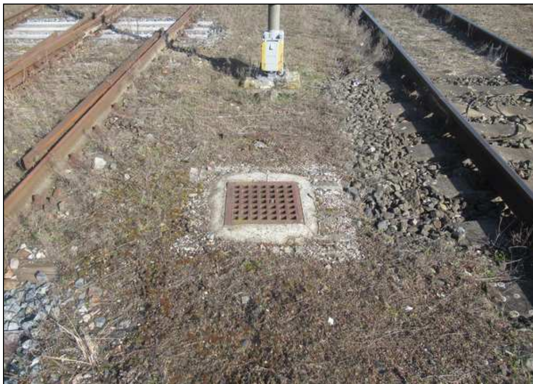
Obr. č. 15 - pohled na šachtu Š6 s novým betonovým soklem
