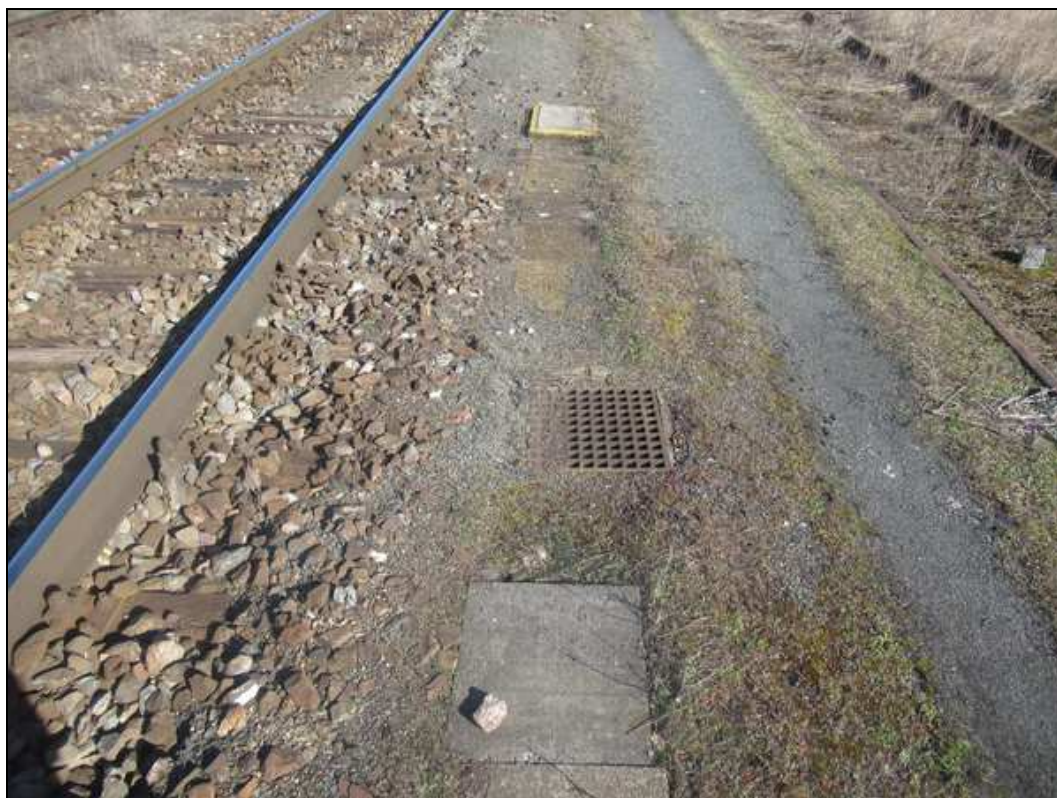
Obr. č. 7 - pohled na šachtu Š3 v trase kabelovodu, bez soklu
