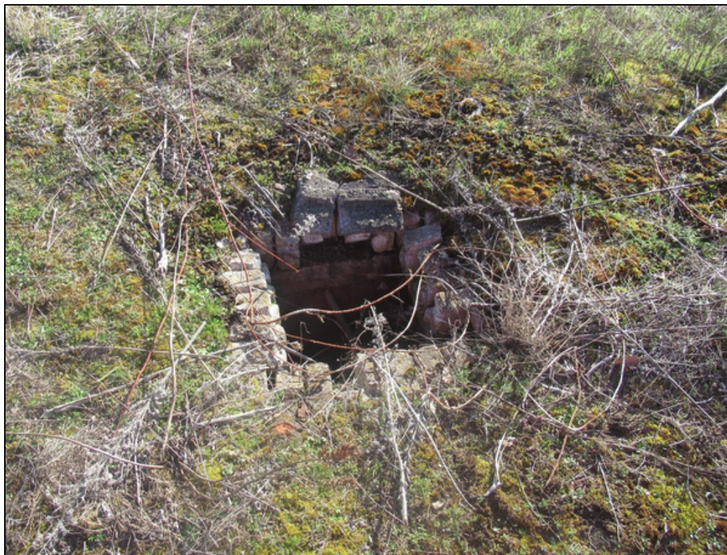
Obr. č. 5 - pohled na šachtu Š2 se zborceným soklem
