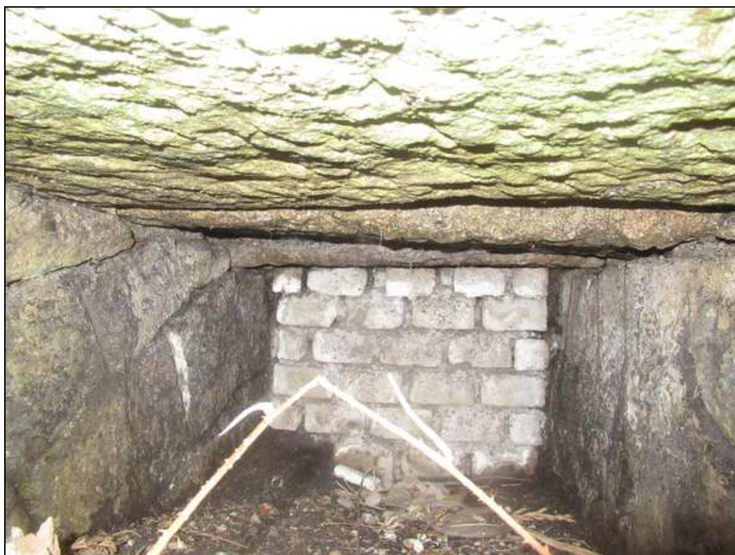
Obr. č. 3 - pohled do šachty Š1 směrem k Š2 - trasa propustku přerušena vyzděnou zídou
