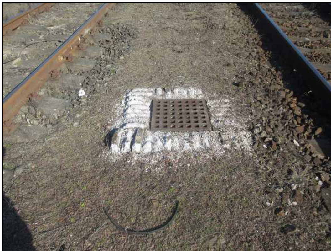
Obr. č. 13 - pohled na šachtu Š5, rozpadající se sokl z betonových cihel
