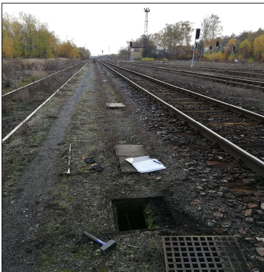
Obr. č. 8 - pohled na šachtu Š3 v trase kabelovodu s otevřeným poklopem
