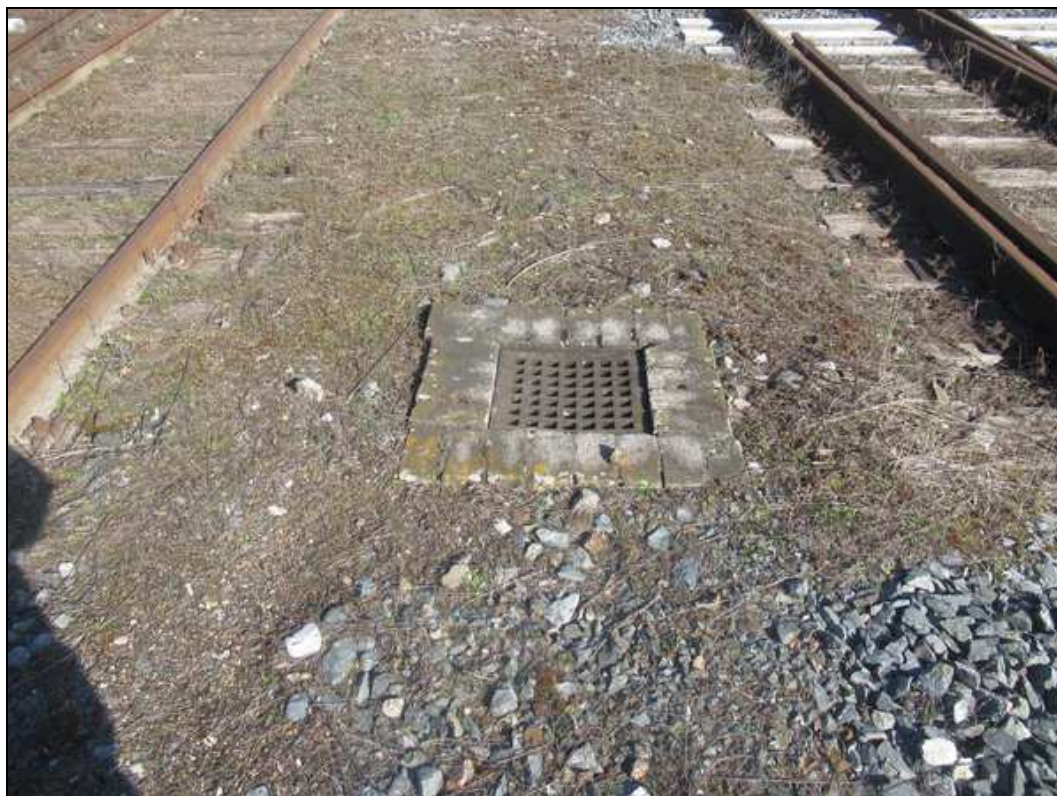
Obr. č. 17 - pohled na šachtu Š7 se zachovalým cihlovým soklem
