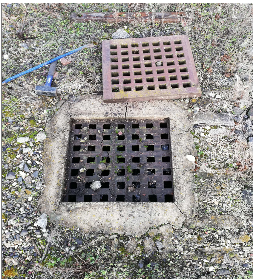
Obr. č. 16 - dvojité zabetonovaný poklop šachty Š6 - nelze otevřít
