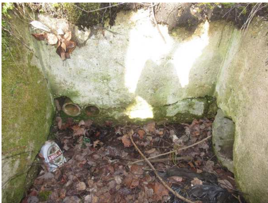
Obr. č. 8 - pohled na pravděpodobně přírodní trubky z pálené hlíny od SZ v šachtě Š4
